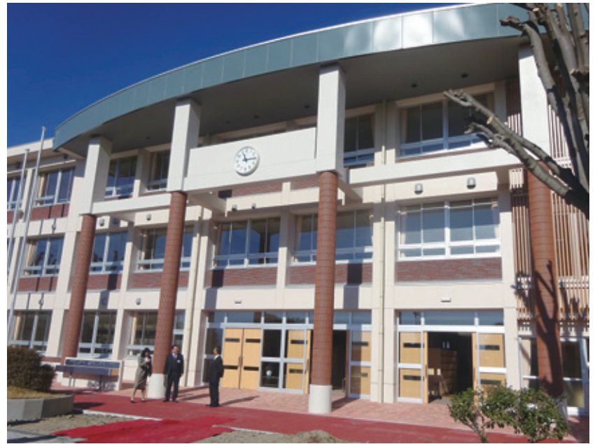
着々と進められる小中学校校舎建設（完成した高南中新校舎）
